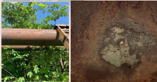
Figura 1: Línea 16” con fuga de DCO. Figura 2: Pinhole de 3mm
