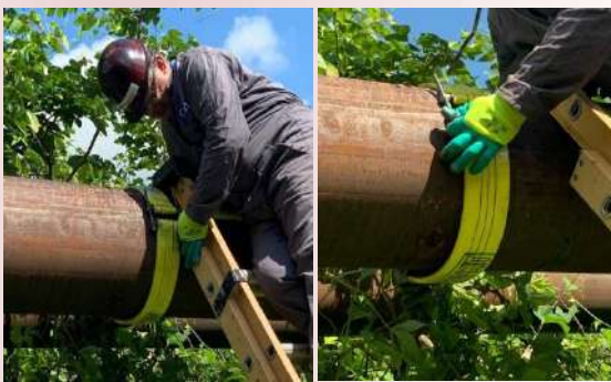
Figuras 5 & 6: una vez bien posicionado sobre la fuga, ambos tornillos del STOPKIT® deben apretarse a 40 N·m.
