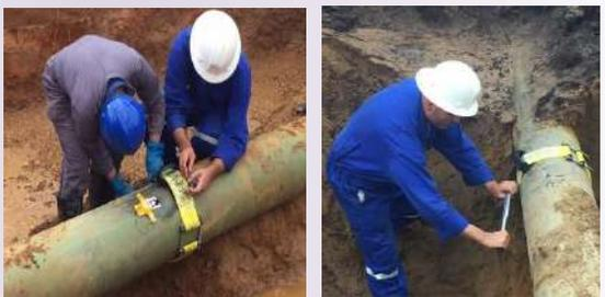
Figuras 6: Posicionamiento y centralizado del **STOPKIT®** por Instaladores certificados de GSA.
