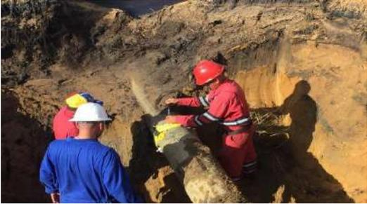
Figuras 9, 10 y 11: Personal técnico de Petromonagas instalando el **STOPKIT®** bajo las instrucciones de GSA.
