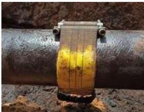
Figuras 12 y 13: **STOPKIT®** instalados con éxito en la tubería. Controladas las filtraciones.
